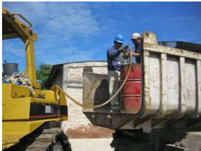
Llenando el tanque de Diesel y polvo
